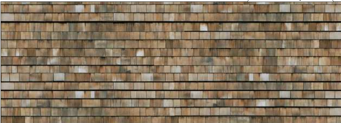
Teil 17 Dachhälfte 1 Scheune Feldseite
