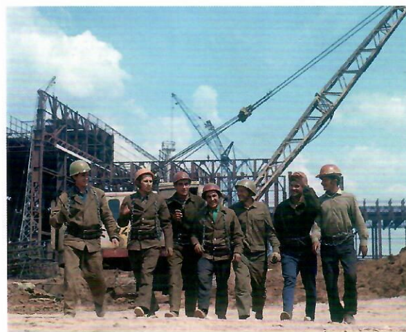
Строительство Камского автомобильного завода. Бригада монтажников-высотников. 1973 г.
