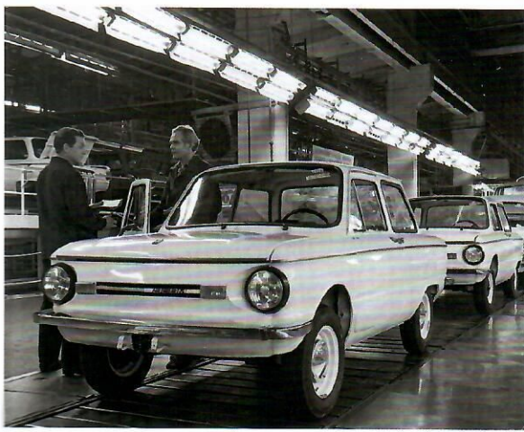
Модифицированный микролитражный автомобиль ЗАЗ-968М «Запорожец» на сдаточном конвейере сборочного цеха. 1979 г.
