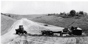
ZIL-MM3-565 и экскаватор на строительной площадке, Везврик, 1962 г.
