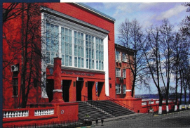
Главный вход в Нижегородский государственный технический университет. Современная фотография.
