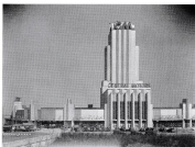
Фасад здания компании «Дженерал Моторс» в Чикаго, США, 1933 г.
