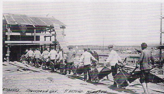
Строительство прессового цеха Горьковского автозавода. 1930 г.
