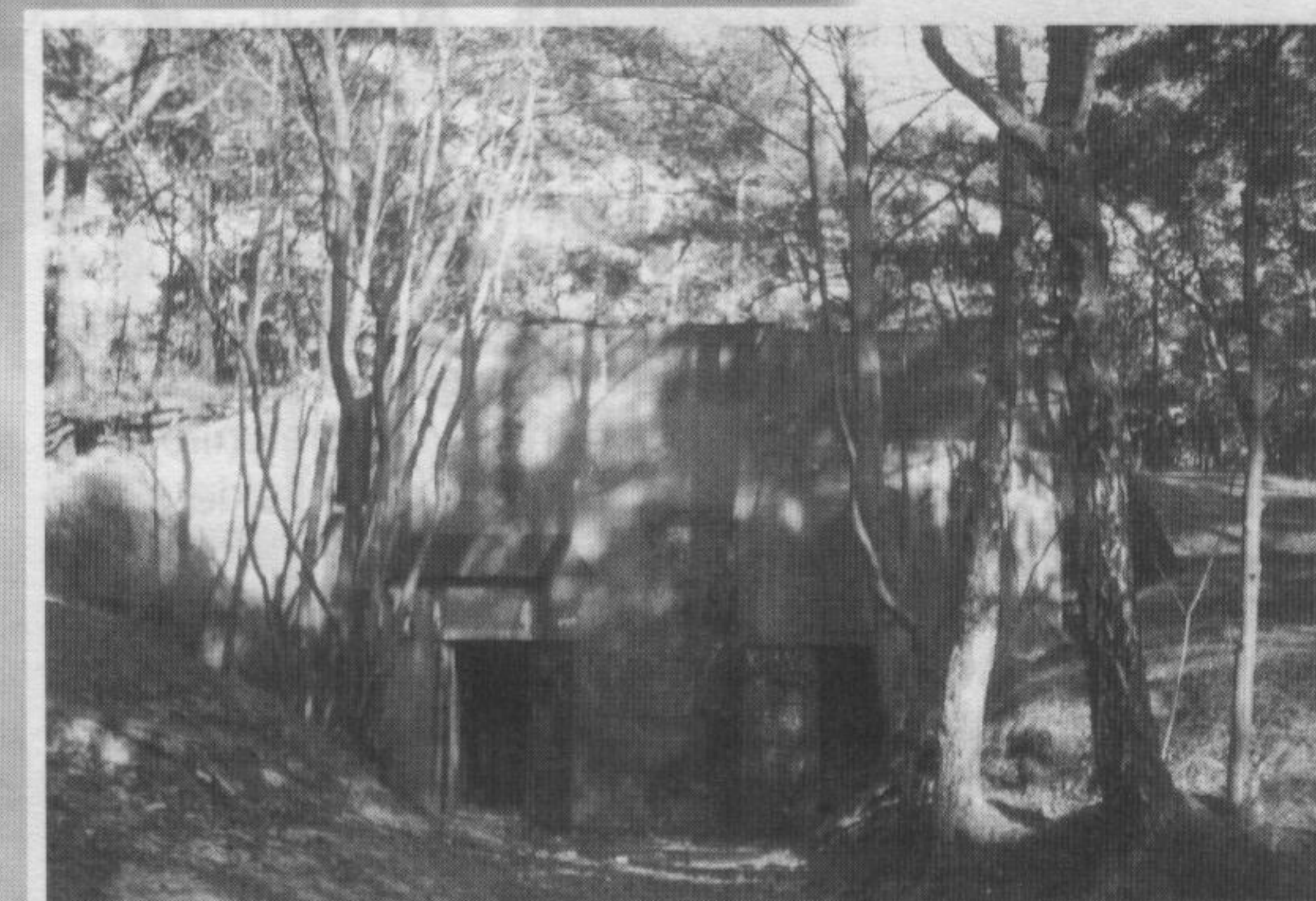
Stanowiska 21 baterii przeciwlotniczej, znajdujące się niedaleko do wyjścia na plażę koło latarni.
